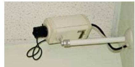
Рис. 2. Внешний вид стационарной цифровой мегапиксельной камеры AXIS-P1344
